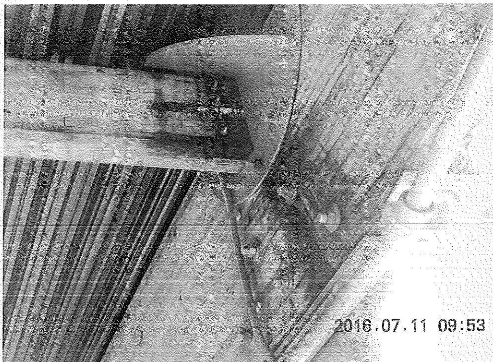
Fot. 13. Miejsce zamocowania płatwi i naciągu na skrajnym dźwigarze. Dźwigar i płatwę z zielonymi nalotami glonów i czarnymi koloniami grzybów pleśniowych. Dodatkowo na płatwi biała grzybnia grzyba składowego.
