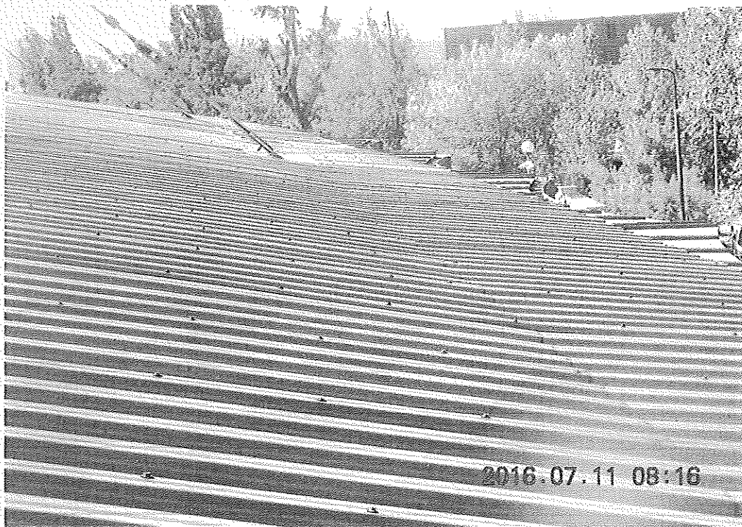
Fot. 2. Połacie dachowa ze zmiennym spadkiem. Stalowe naciągi zamocowane w strefie zmiany spadku.
