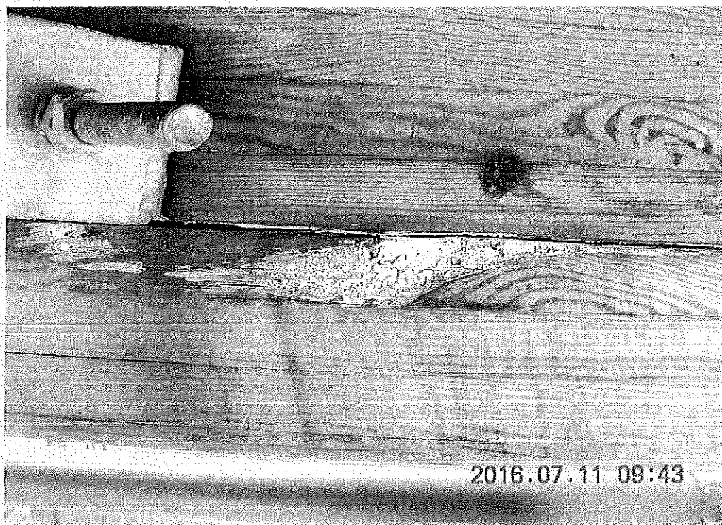
Fot. 11. Kolejny dźwigar- zielone naloty glonów, czarne kolonie grzybów pleśniowych, biała grzyb- nia i owocnik grzyba składowego. Owocnik spękany, oddzielający się od podłoża.
