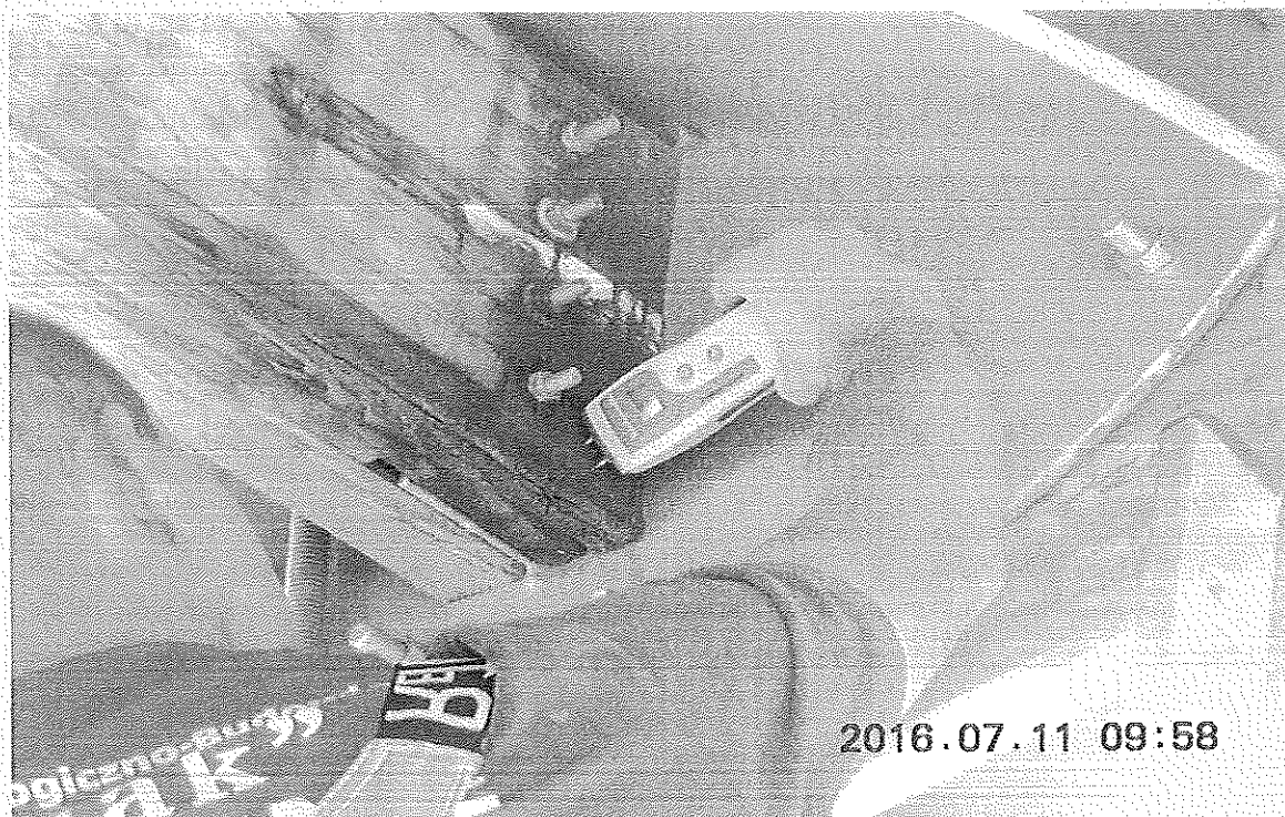
Fot. 14. Płatwę jw. Powierzchnia płatwi sucha ; podpowierzchniowo utrzymuje się silne zawilgocenie. Warstwy płatwi ulegają rozklejaniu; nastąpiła korozja śrub.
